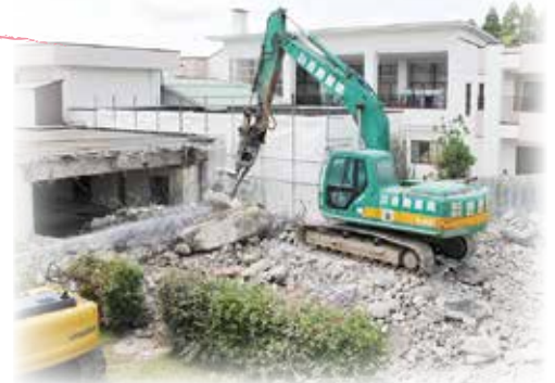
旧やまびこ棟解体工事の様子 (H26.7.1)
